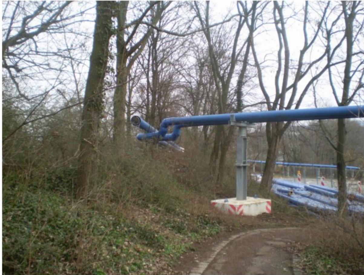
Bild 044: Rohrbrücke über Fußweg an Ehmman-Strasse, im Hintergrund vorab verlegte Verbundleitung DN 200 (nicht genehmigt)
